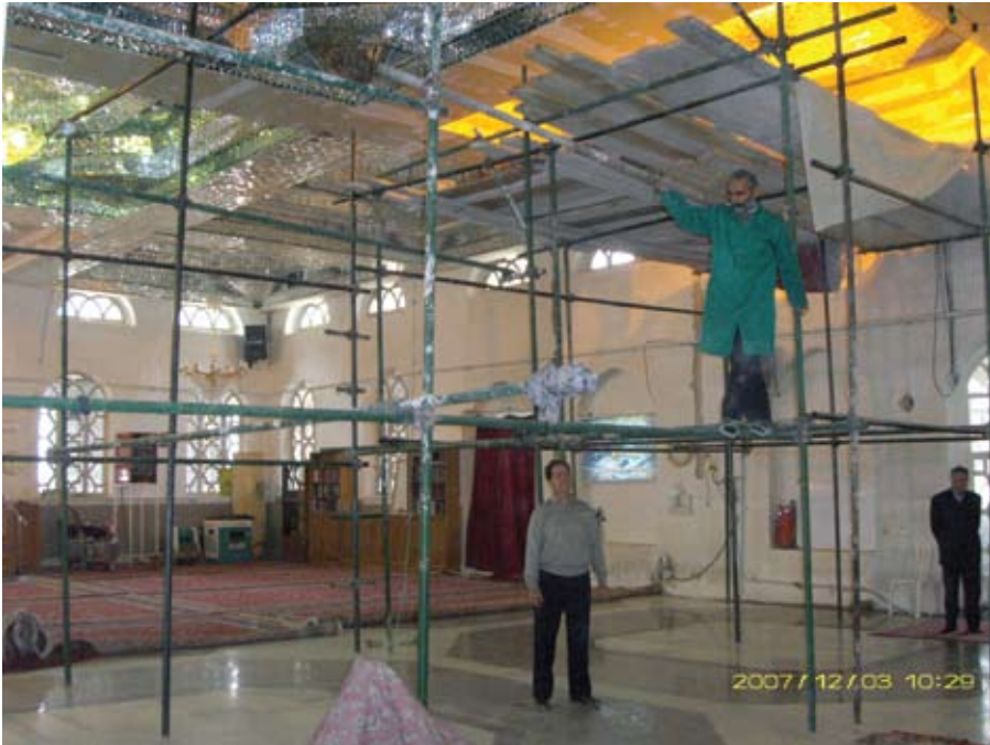
أعمال التزجيج بالمرايا والنقوش لا تزال جارية في باحة الحرم.. (ميامي)
