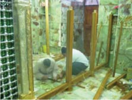
نصب القواطع بين حرم الرجال وحرم النساء
