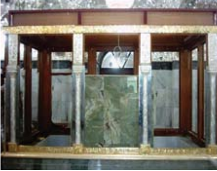
نصب هيكل الشباك الذهبي
